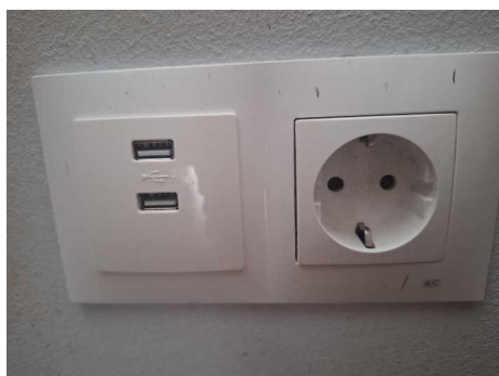
Fig. 3 Tomas USB instaladas.
